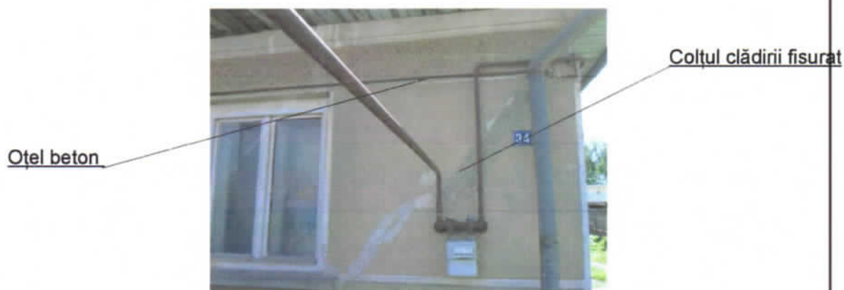
Foto. 3. Colșul deteriorat a clădirii
